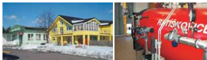
Technologie parní kotleny určená pro výrobu polystyrenu i pro vytápění firmy POLYSTYREN, s.r.o. v Bojkovicích (využití programu Malý Kredit)
